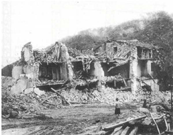
Slika 2. Podbela, 1976: srušena zidana kuća od kamena
