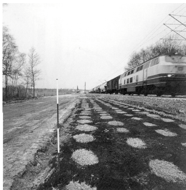
Slika 6. Šljunčani stupovi nakon izvođenja [4]
