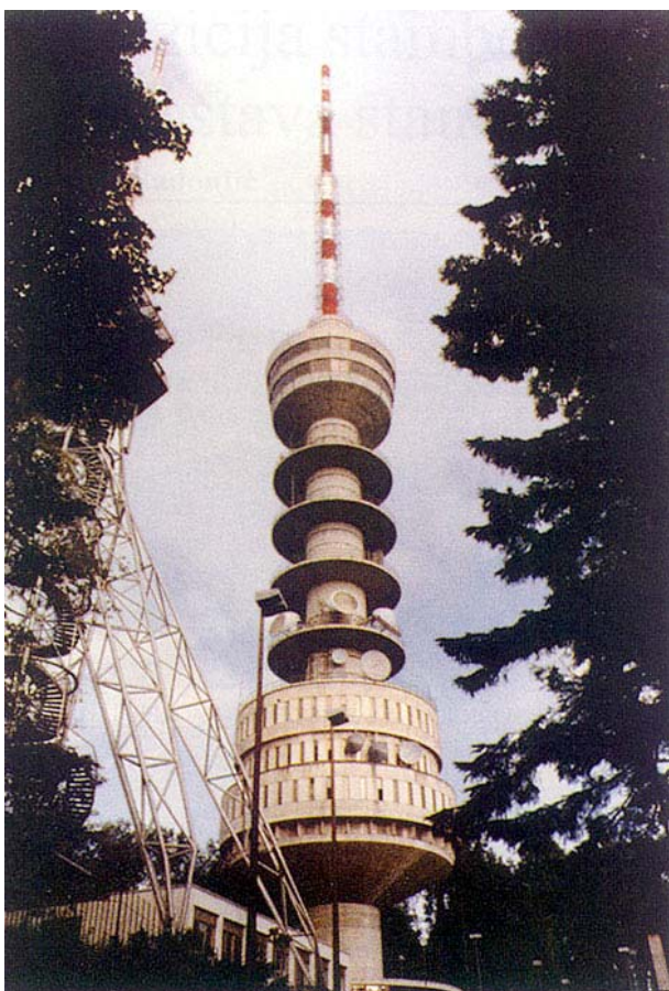
Slika 6. Pogled na završeni toranj
