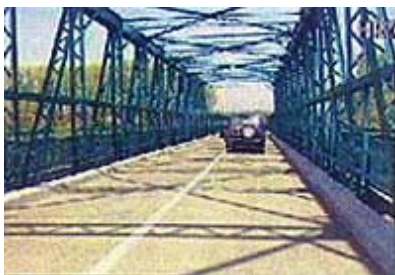
Obnovljeni most na cesti Županja - Brčko
