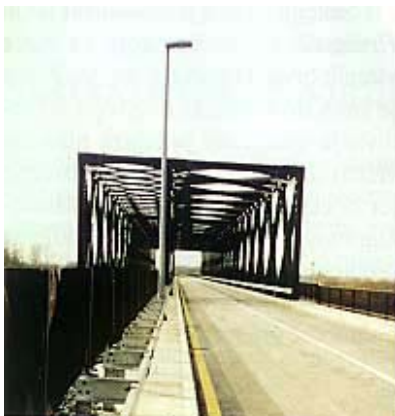
Pogled na most s ruba cestovnog kolnika
