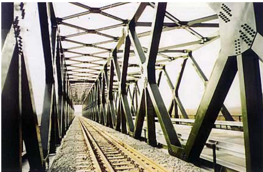
Željeznički i cestovni dio mosta
