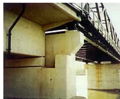
Upornjak i početak čelične konstrukcije mosta
