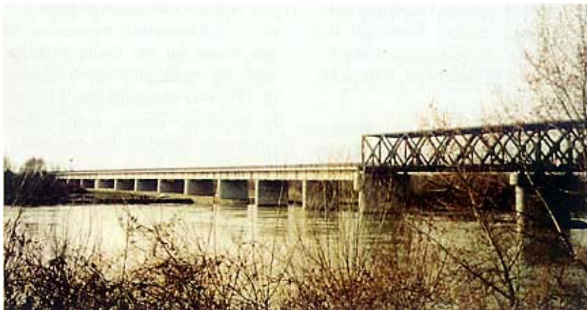
Betonski dio mosta i dio čeličnog dijela
