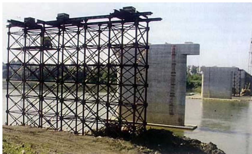
Faza pripreme za montažu čelične konstrukcije
