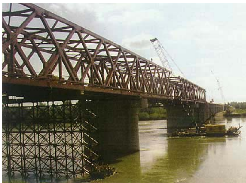
Zadnja faza montaže čelične konstrukcij
