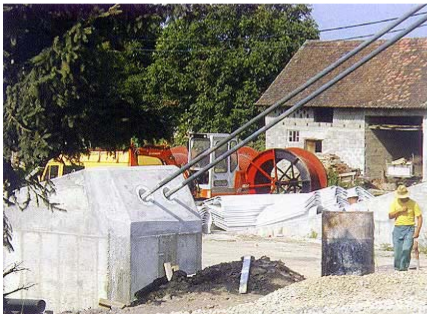
Jedan od sidrenih blokova
