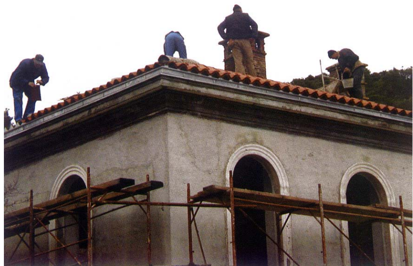
Obnova općinske zgrade
