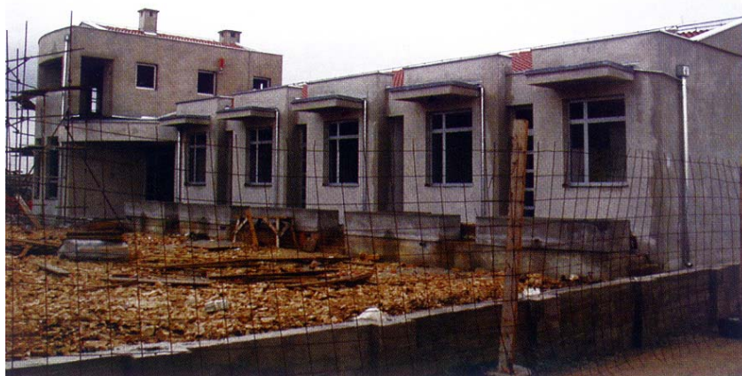
Gradilište područne osnovne škole Rupalj
