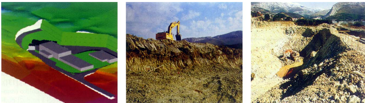
Slika 3. Iskop na lokaciji UPOV-a Stupe u (I etapa): vizualizacija projektnog rješenja (lijevo), široki iskop (sredina i desno)
