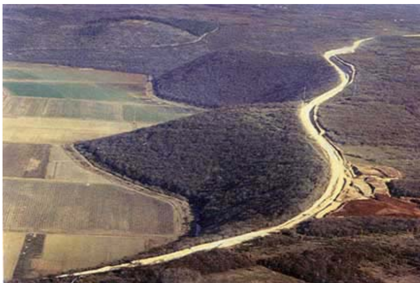
Prilazna cesta gradilištu mosta
