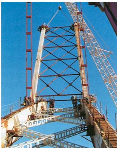
Montaža stupa nadlučne konstrukcije
