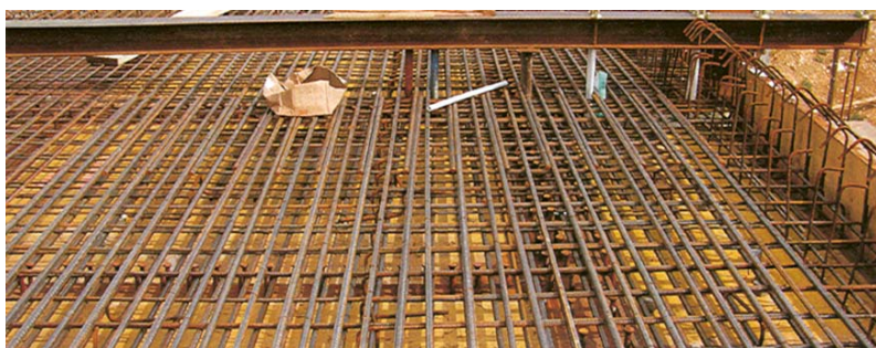
Armatura kolničke ploče
