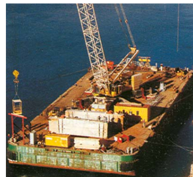
Ploveća platforma s koje se montiraju dijelovi mosta
