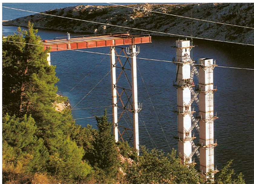
Gradilište na starigradskoj strani u fazi izvedbe portalnog stupa
