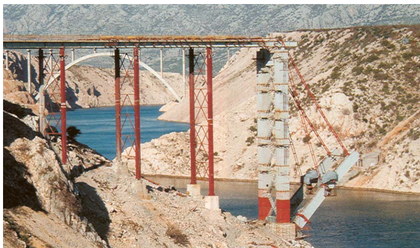
Pogled kroz gradilište Mosta Maslenica na autocestovni Maslenički most
