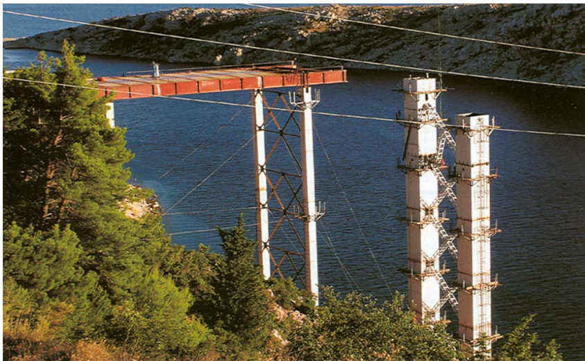
Pogled na gradnju mosta u početku montaže lukova
