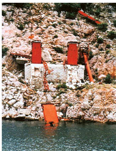
Detalji ostataka uz oslonce lukova nakon rušenja. Lijevo: na starigradskoj strani; desno: na zadarskoj strani
