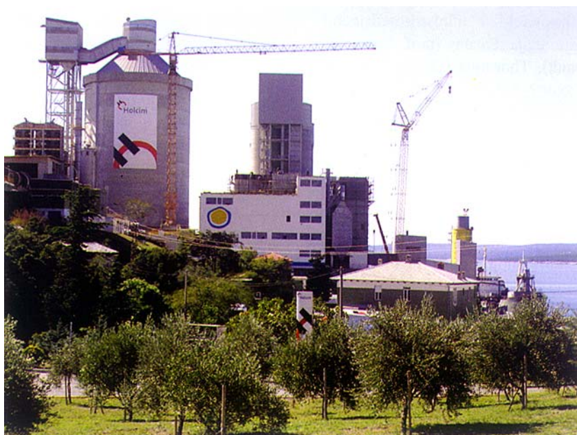
Holcimova tvornica u Koromačnom
