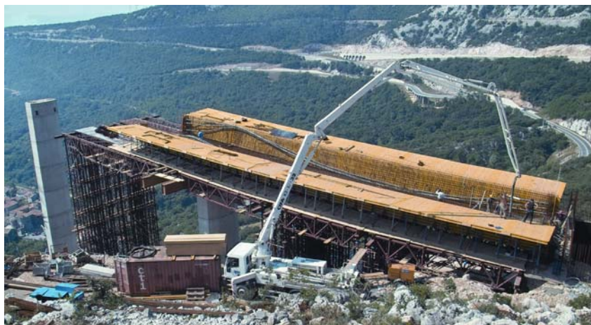
Oplata prvog segmenta – stup S2
