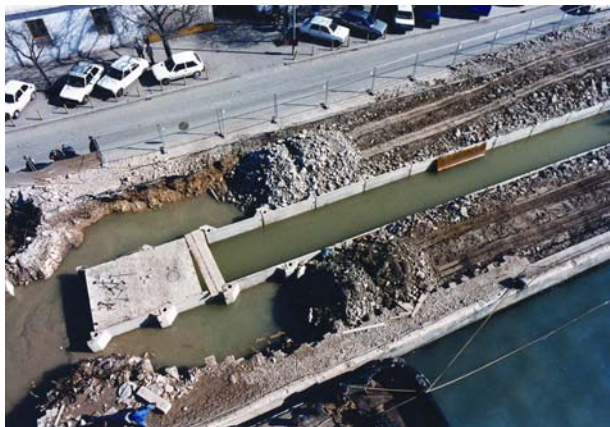
Slika 4. Ugradnja betonske "kade" spojene sustavom utor-pero
