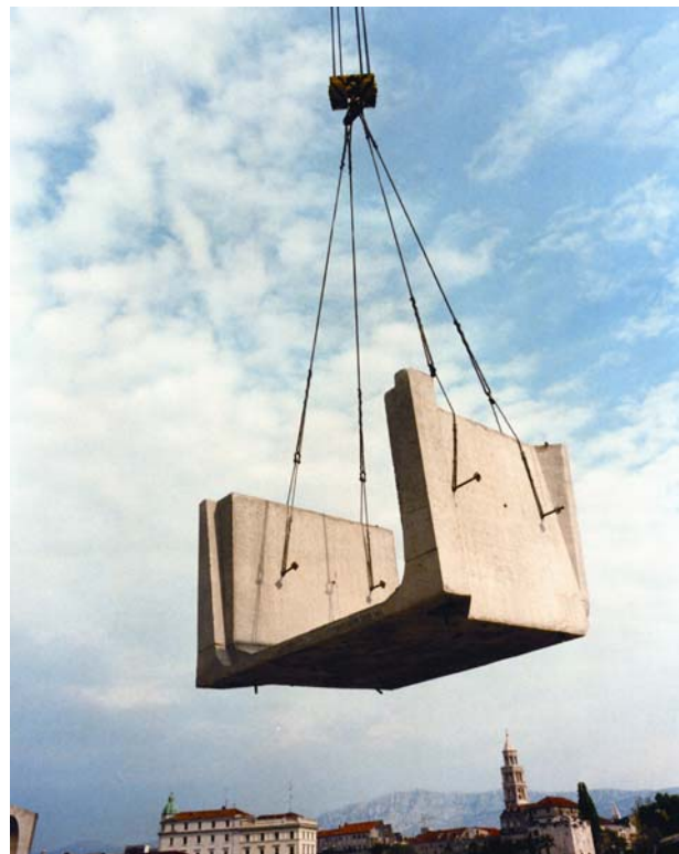
Slika 3. Prenošenje ugradbenih elemenata - "kada"
