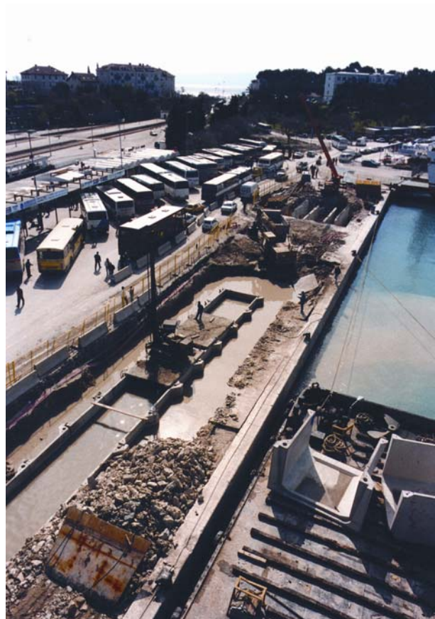
Slika 8. Radovi na obalnoj dionici pred autobusnim kolodvorom
