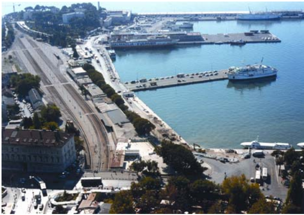
Slika 2. Pogled sa sjevera na gradsku luku, vidi se dio trase na području Hrvatskih željeznica
