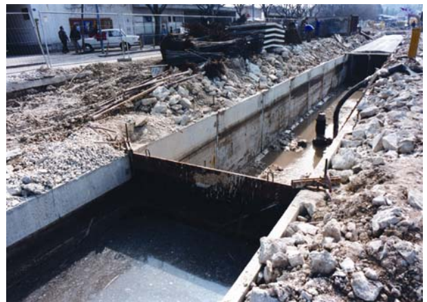
Slika 5. Faze izvedbe kolektorskog kanala, dio je kanala betoniran s postavljenom izolacijom, na drugom dijelu priprema se za betoniranje, a na trećem je još neispravljeni dio kanala odvojen zagatom
