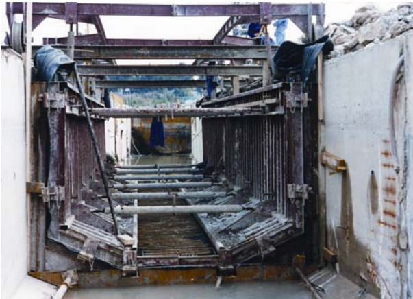
Slika 6. Oplata za betoniranje kanalskog presjeka u kampadama
