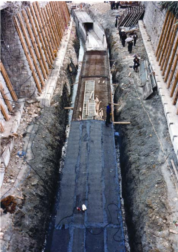
Slika 7. Radovi na dijelu ukopa pruge (prostor HŽ-a), vidi se osiguranje lučnih potpornih zidova
