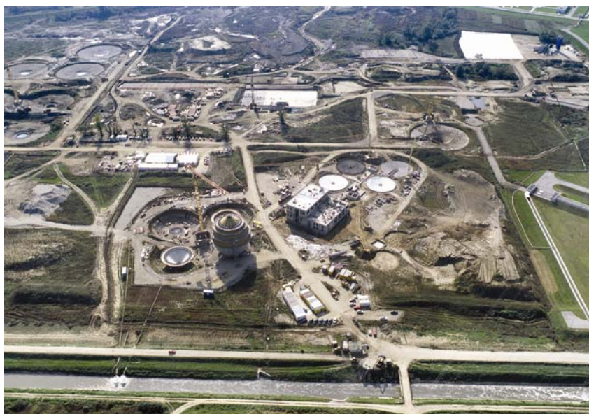
Pogled na gradilište CUPOVZ-a sa sjevera
