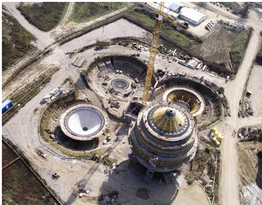
Gradilište digestora iz zraka
