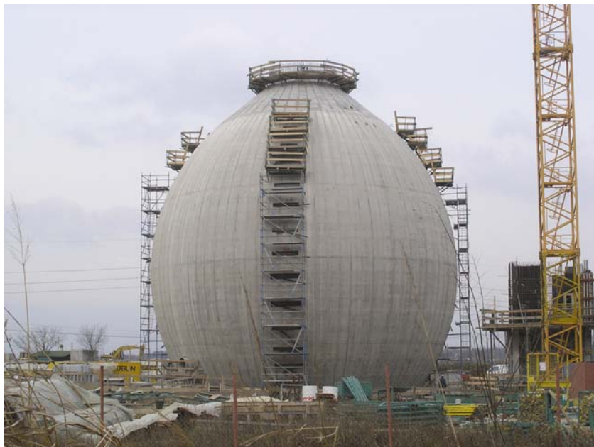
Jedan od gotovih digestora snimljen sa zemlje
