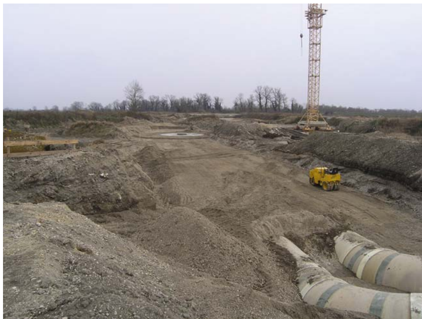
Polaganje cijevi prema naknadnom taložniku
