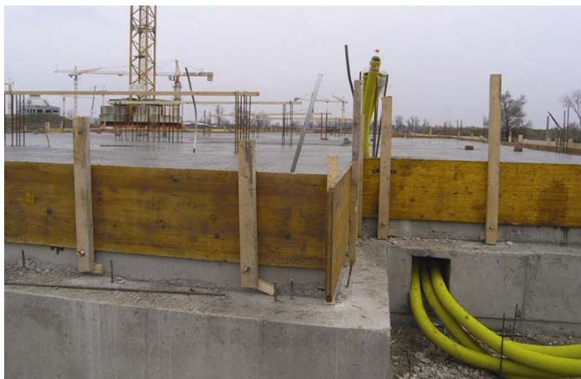
Radovi na gradnji pogonske zgrade
