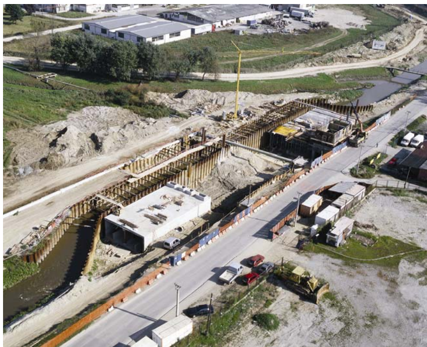
Radovi na zatvaranju GOK-a
