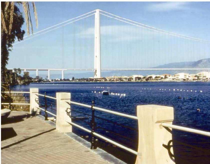
Pogled na dio mosta sa najsjevernije točke Mesinskog tjesnaca
