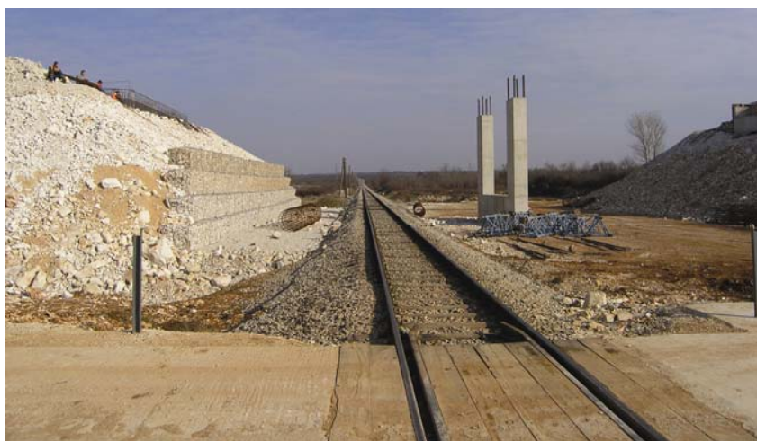
Radovi na prijelazu željezničke pruge
