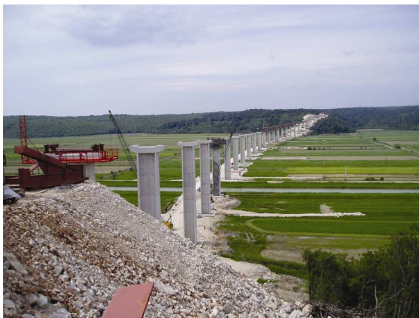
Vijadukt Mirna tijekom gradenja
