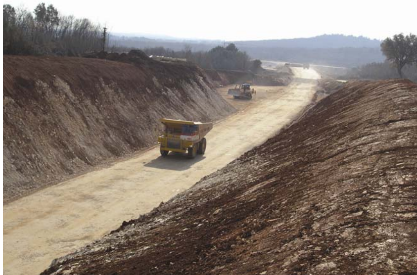
Radovi u usjeku
