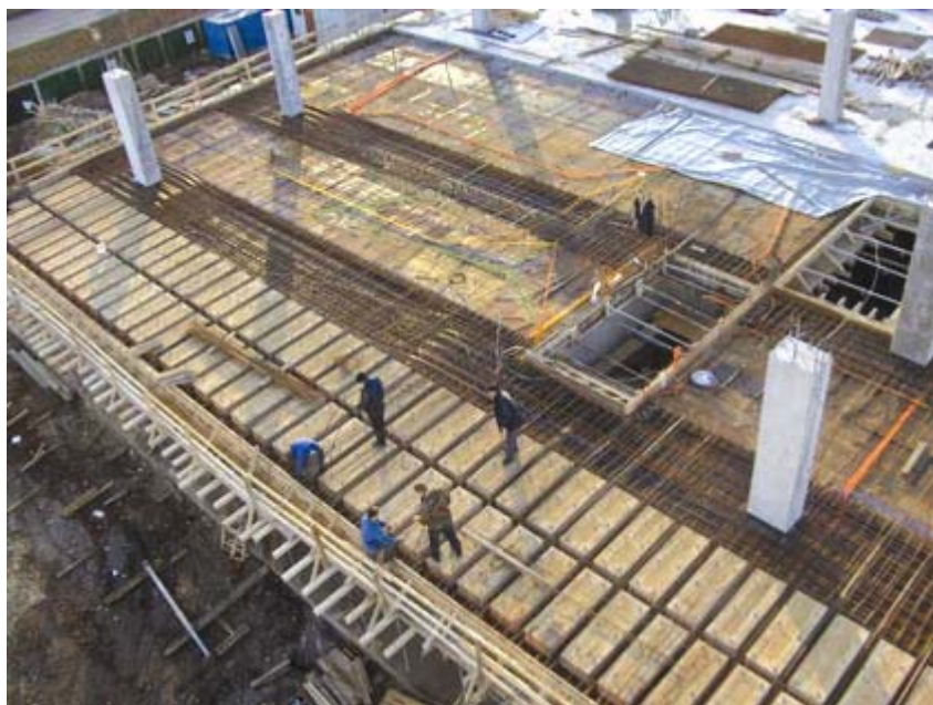
Izvedba trećeg dijela ploče prizemlja
