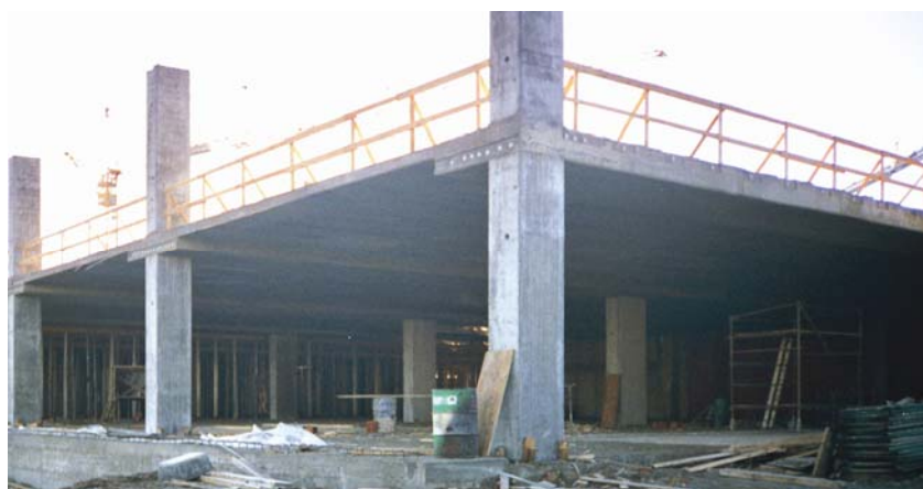
Pogled na prvi dio ploče nakon skidanja oplata
