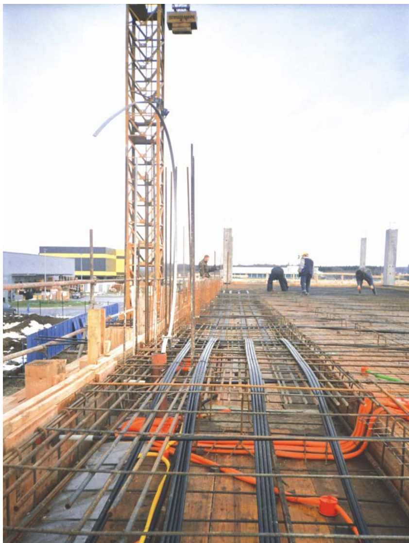
Postavljeni kabeli u zoni zadebljanja ploče
