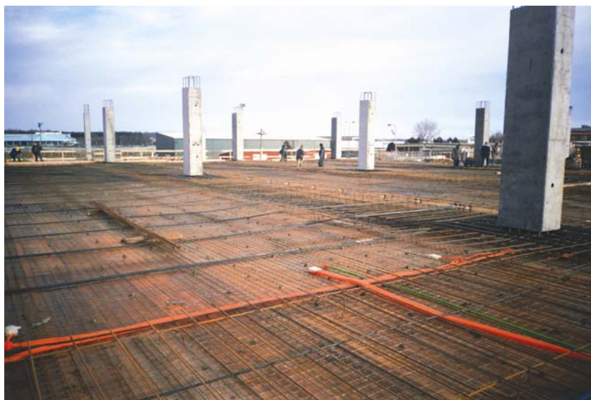
Prvi dio ploče prizemlja prije betoniranja
