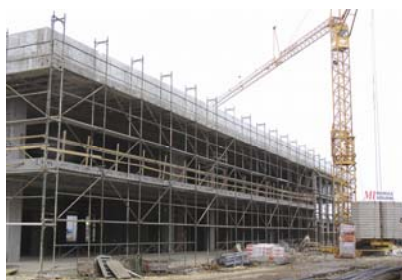
Pogled na izvedene ploče
