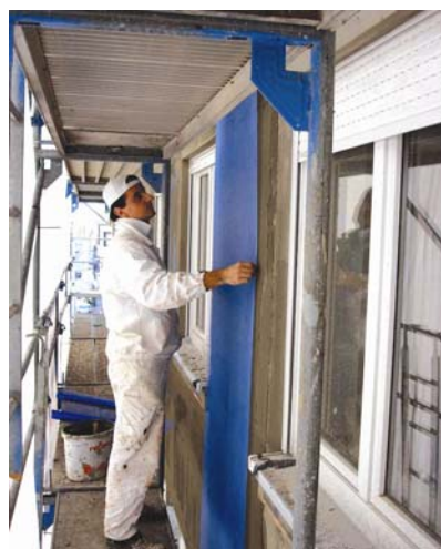
Alkalno otporna staklena mrežica uvijek se postavlja u istome smjeru, utisne se u svježe ljepilo i odmah zagladi od sredine prema krajevima
