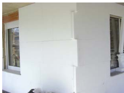
Na uglovima i kutovima ploče se moraju sudarati izmjenično u svakom sljedećem redu
