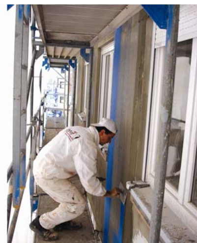
Alkalno otporna staklena mrežica uvijek se postavlja u istome smjeru, utisne se u svježe ljepilo i odmah zagladi od sredine prema krajevima
