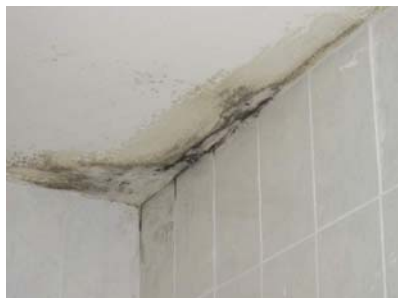
Keramičke su pločice spriječile pojavu gljivica ali nastaju na stropu
