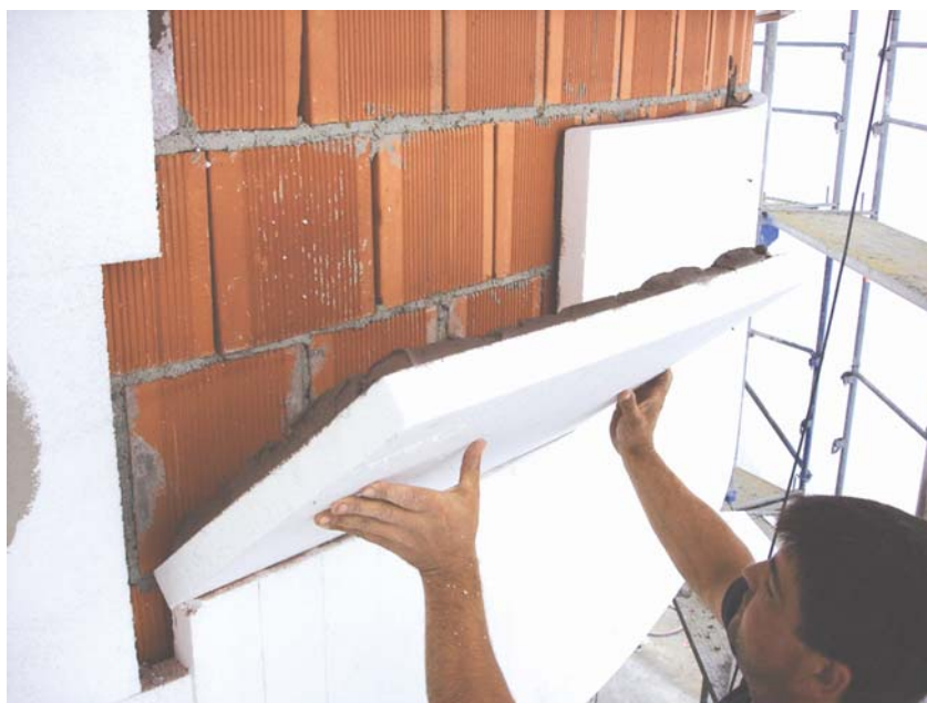
Ploče se pritisnu na podlogu odmaknute od susjednih ploča i zatim uz njih tijesno priljube
