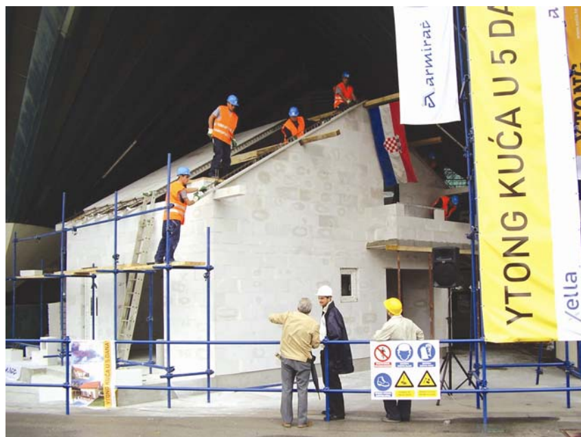
Gradnja kuće – od temelja do krova u pet dana trajanja sajma
