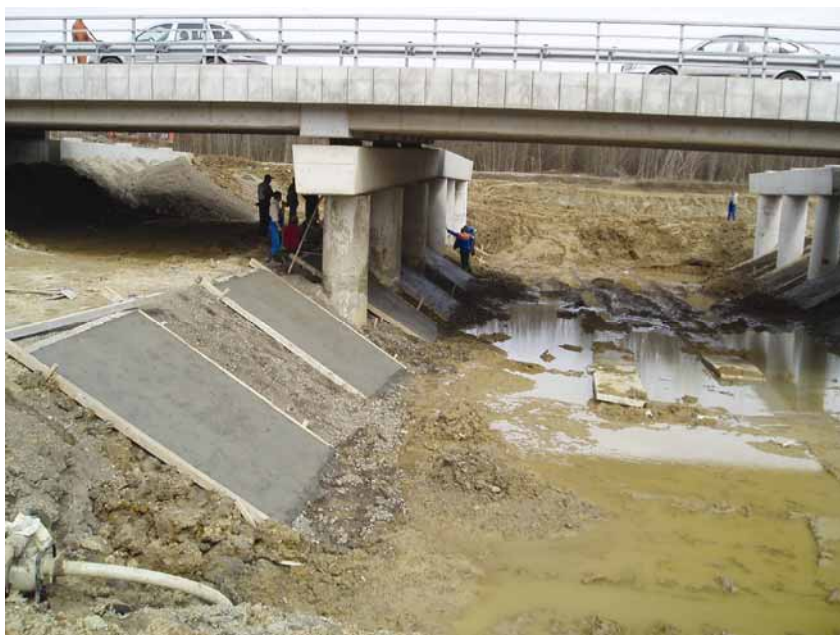
Izrada obloge korita ispod mosta Brežnica
