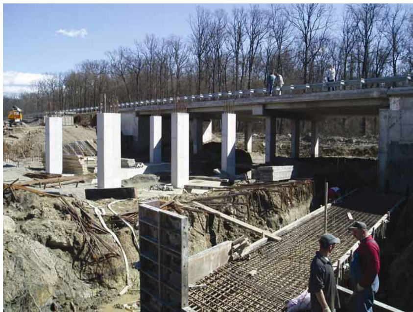
Radovi na mostu Ljubanj 1
