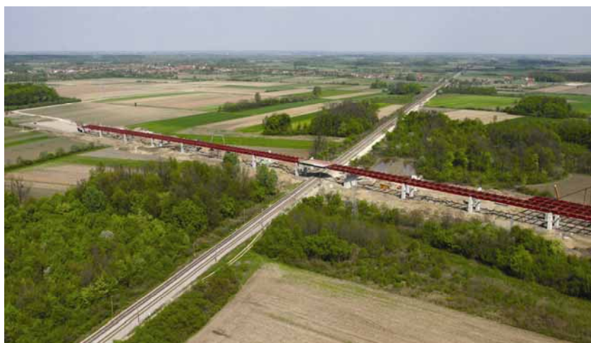
Pogled iz zraka na nadvožnjak preko željezničke pruge Zagreb – Vinkovci
