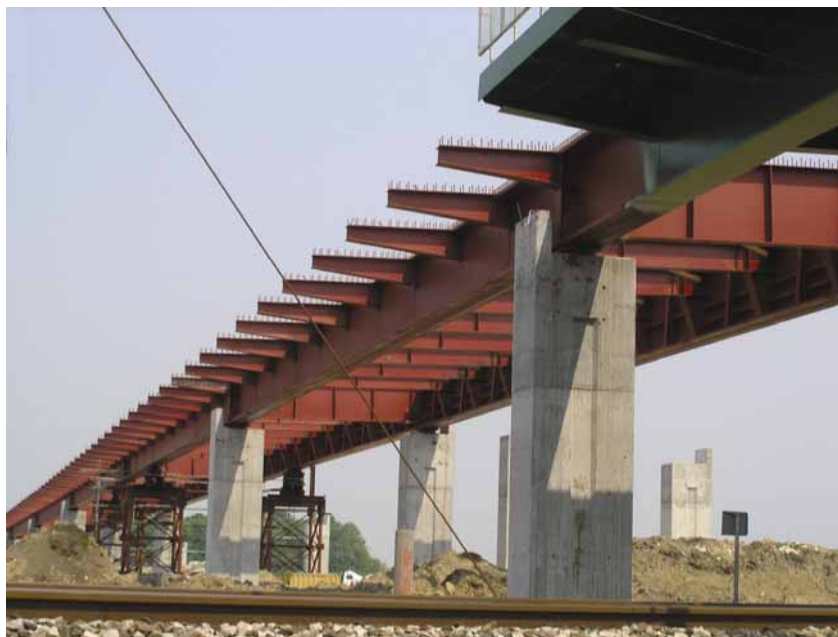
Radovi na nadvožnjaku preko željezničke pruge
