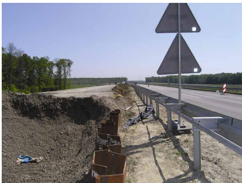
Radovi na trasi (poddionica Spačva – Lipovac)
