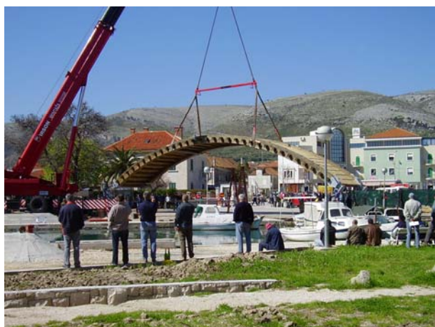
Slika 10. Montaža rasponskog sklopa autodizalicom
