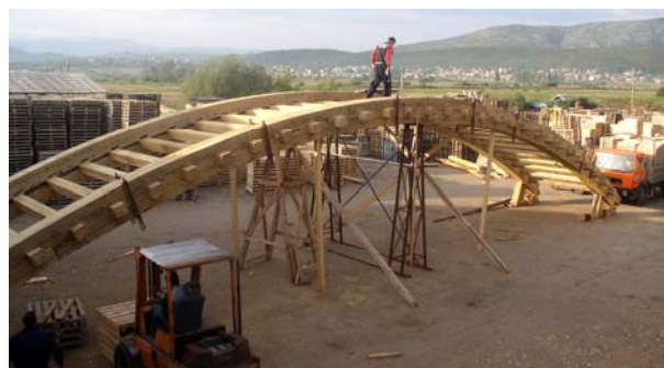
Slika 8. Probna montaža lukova i poprečnih greda u radionici
