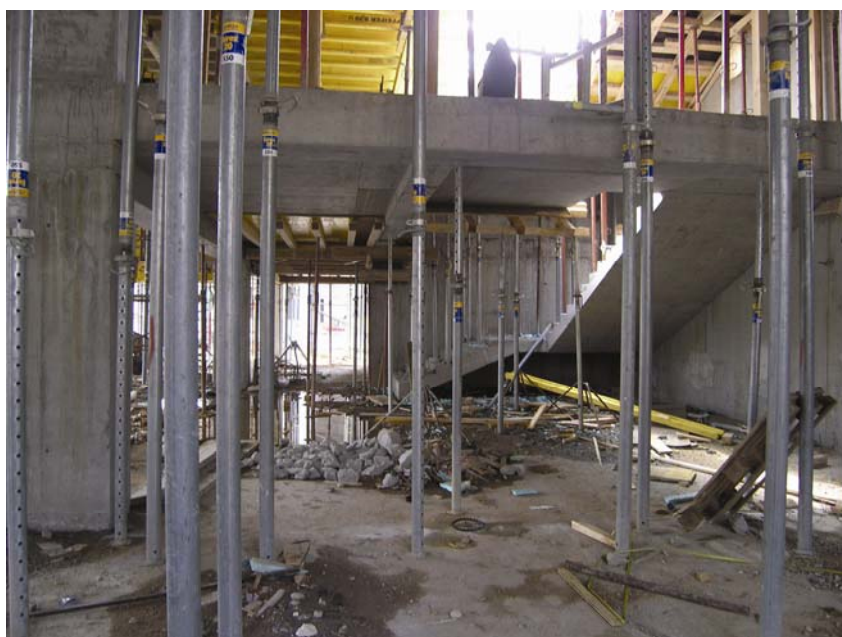
Prizemlje budućega kazališta u gradnji
