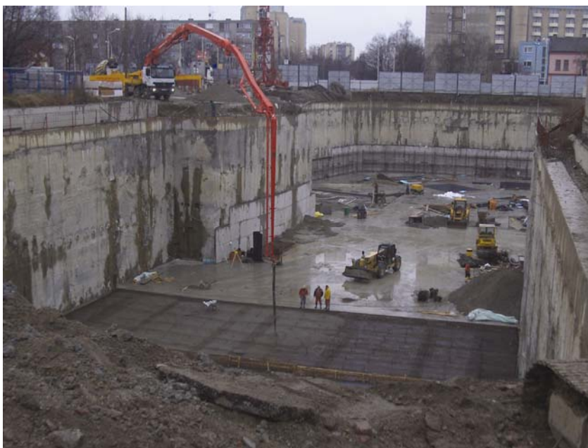
Izvedba temeljne ploče
