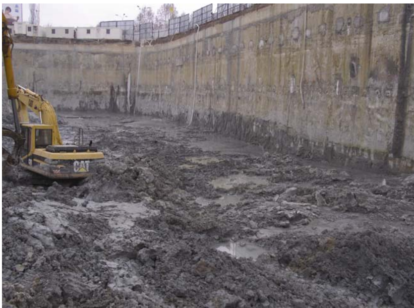
Iskopi u građevnoj jami
