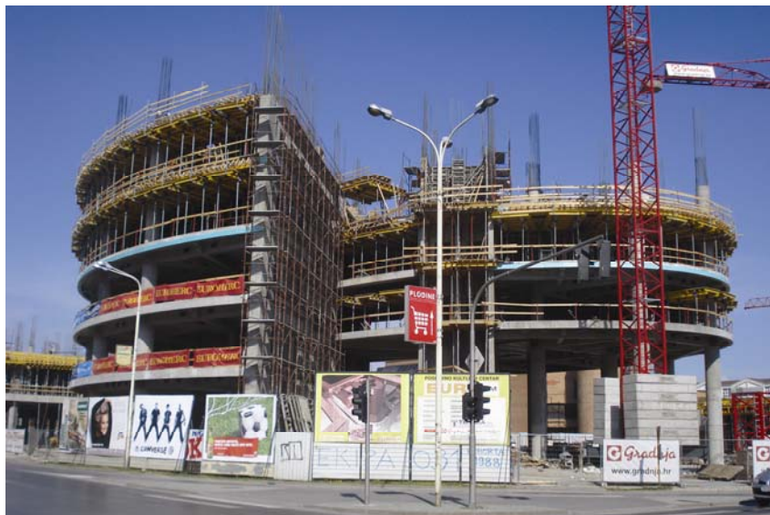
Gradilište tornjeva blizanaca na uglu Vukovarske i Trpimirove ulice
