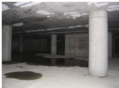
Detalj podrumskih garažnih prostora
