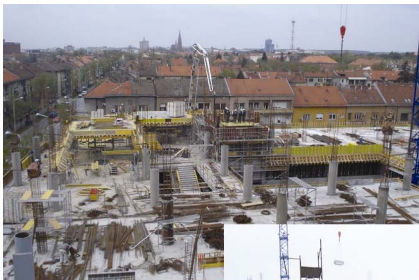
Pogled s tornja na gradilište
