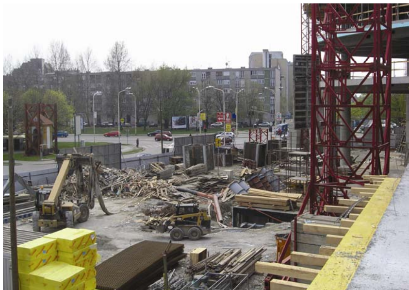
Pogled na dio gradilišta i raskrižje Vukovarske i Trpimirove ulice
