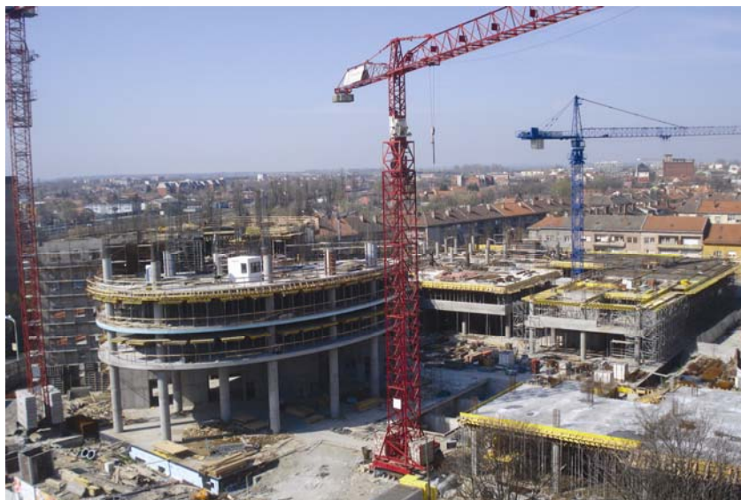
Gradilište snimljeno iz smjera Trpimirove ulice
