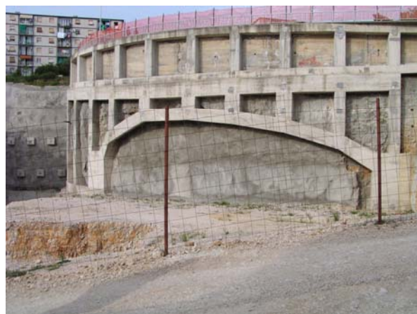
Slika 20. Pogled na budući izlazni portal priključka Rijeka - TCR
