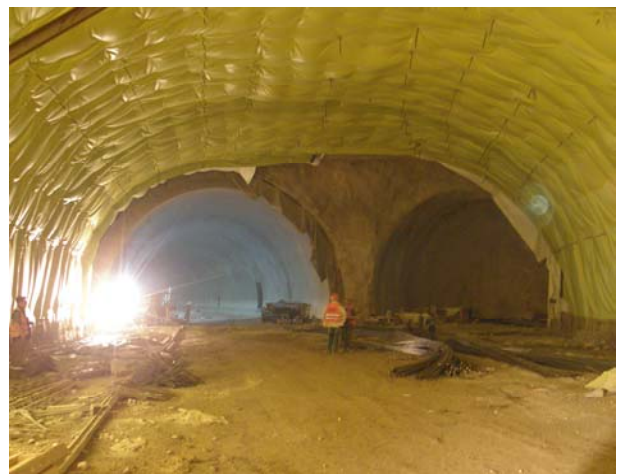
Slika 3. Postavljanje hidroizolacije u račvi - istok
