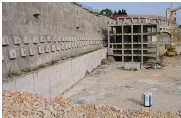
Slika 21. Građevna jama TCR-a, pogled na pokos iza kojeg prolazi trasa tunela
