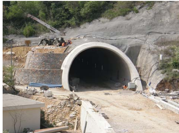
Slika 25. Istočni (izlazni) portal tunela
