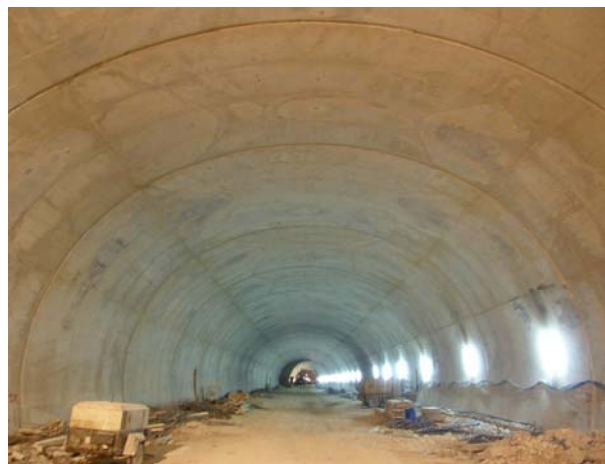
Slika 23. Tunel uz građevnu jamu TCR-a – sekundarna obloga
