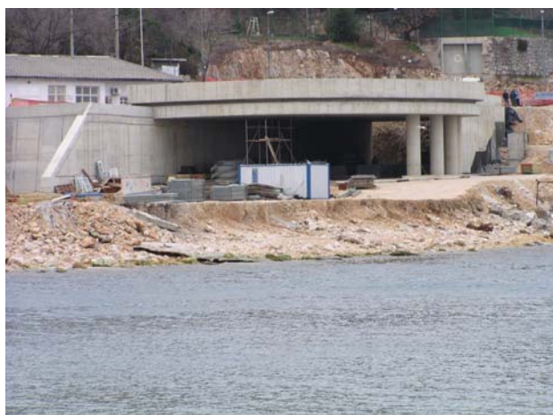
Slika 9. Portalna građevina Pećine tijekom gradnje
