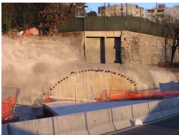
Slike 10. Prolaz tunela ispod teniskog igrališta – ulazni portal
