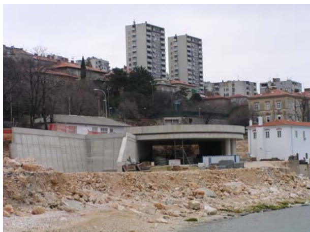
Slika 14. Prolaz tunela ispod četrnaesterokatnice
