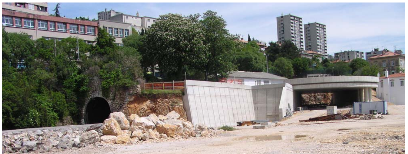
Slika 12. Portal željezničkog tunela Brajdica i portalna građevina tunela Pećine neposredno pred početak iskopa tunela
