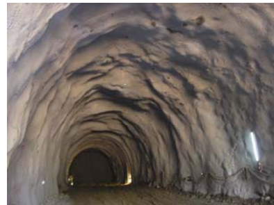
Proboj lijeve (južne) cijevi tunela Škurinje
