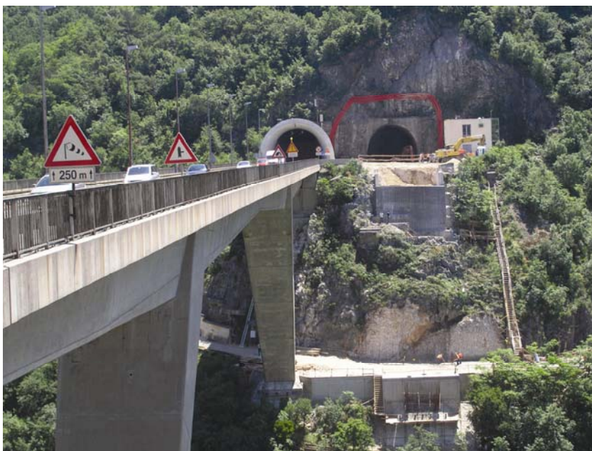
Pogled na gradilište mosta i tunela sa zapadne (rijeka) strane
