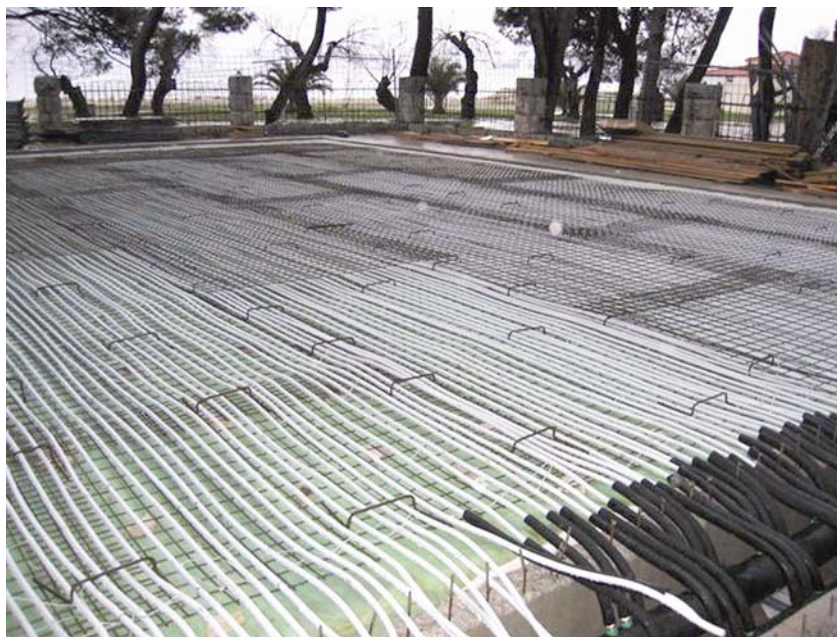
Razvod cijevi za klizalište
