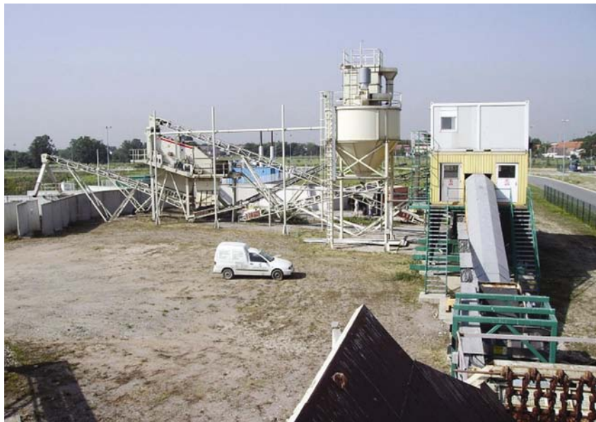
Postrojenje za odvajanje otpada na odlagalištu Jakuševac
