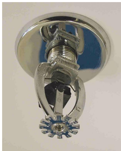
Sprinkler ugrađen u strop
