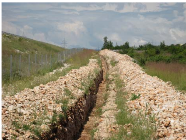
Slika 6. Rov tranzitnog cjevovoda iskopan bagerom s hidrauličkim udarnim čekićem
