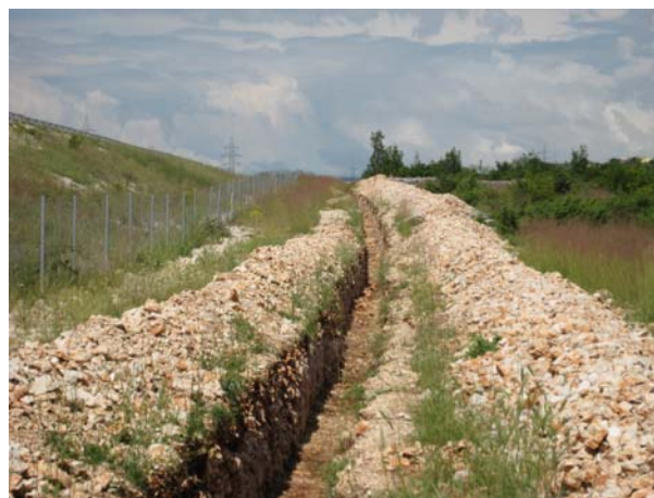
Slika 7. Rov tranzitnog cjevovoda iskopan rovoglodačem
