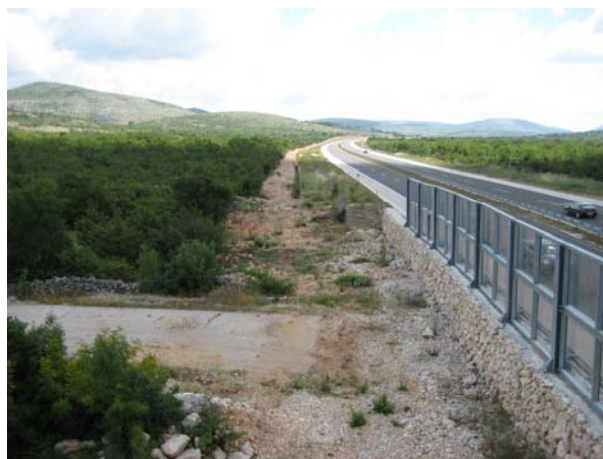
Slika 2. Pogled na iskopani rov tranzitnog cjevovoda uz trasu autoceste
