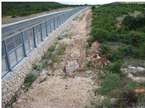
Slika 5. Rov tranzitnog cjevovoda obraden bagerom s hidrauličnim udarnim čekićem
