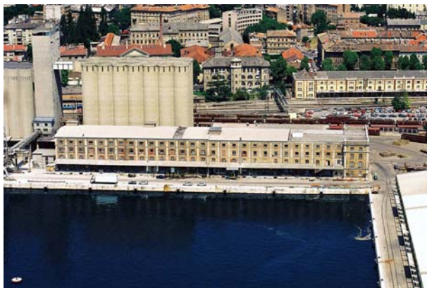
Slika 4. Lučka skladišta 12 i 13 na Budimpeštanskom pristaništu, autori Luigi Lajos Burgstaller i Vjenceslav Celligoi, 1893. – 1897., (foto D.K)
