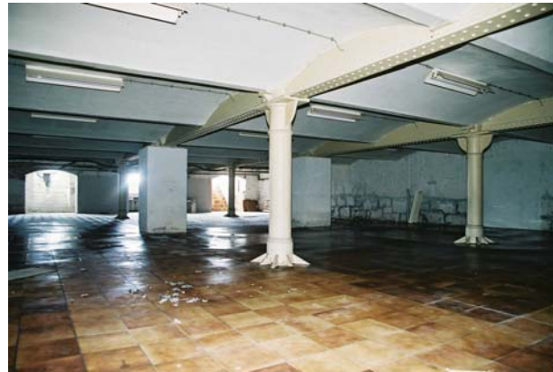
Slika 3. Lučko skladište 13 na Budimpeštanskom pristaništu, autor Vjenceslav Celligoi, 1897., Monierova stropna konstrukcija u podrumu (foto D.K)
