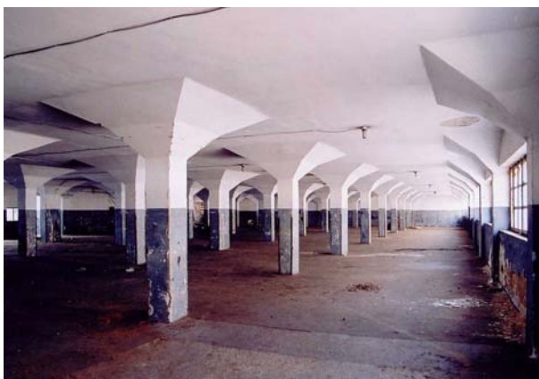
Slika 11. Javna i slobodna carinska skladišta na Sušaku, autor Milan Čalogović, 1931. – 1937., gljivasta stropna konstrukcija 2. kata (foto D.K.)
