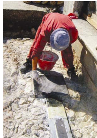
Slika 8. Posipanje zone sidrenja kvarcom radi bolje prionjivosti
