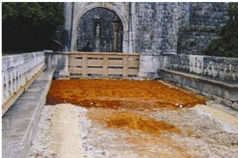
Slika 10. Obrada zone ojačanja vapnenim mortom i nasipavanje tampona
