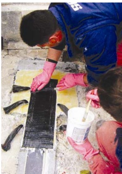
Slika 6. Lijepljenje karbonske užadi na zonu sidrenja
