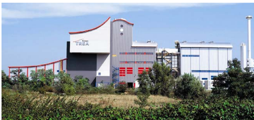
Postrojenje u Breisgau u Njemačkoj
