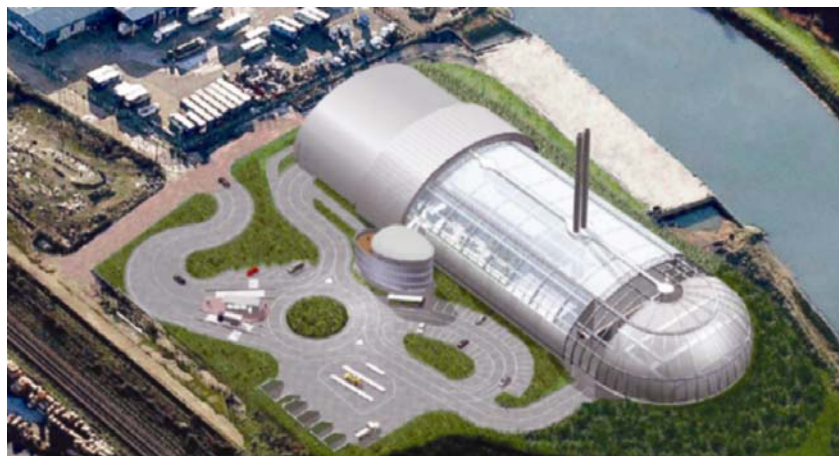
Postrojenje u Newhavenu u Velikoj Britaniji
