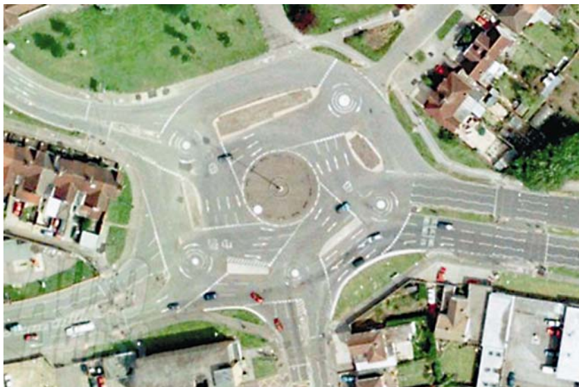
Pogled odozgo na Magic Roundabout
