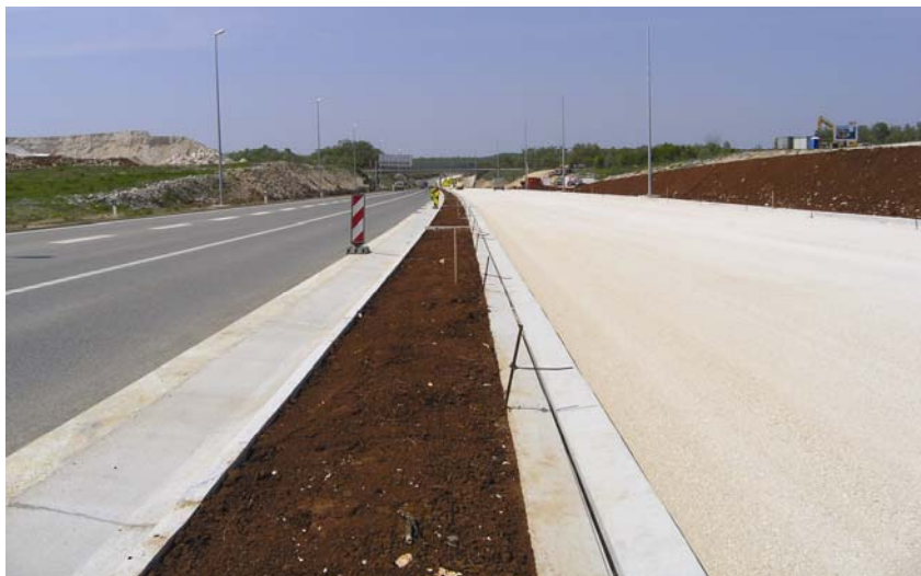
Priprema za početak asfaltnih radova na jednom dijelu zapadnog kraka Istarskog ipsilona
