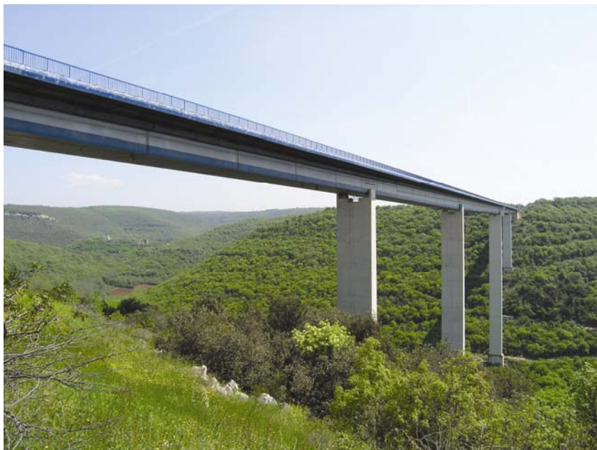
Vijadukt Limska draga na poluautocesti
