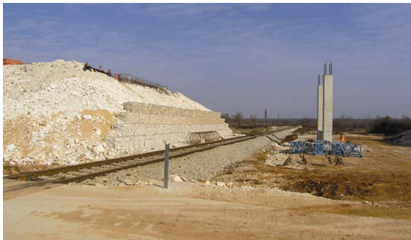
Izvođenje prijelaza preko željezničke pruge u prvoj fazi izgradnje
