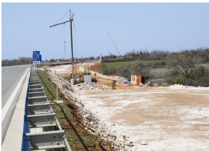
Radovi na Vijaduktu Cirka na dionici Vodnjan-Pula početkom 2009.
