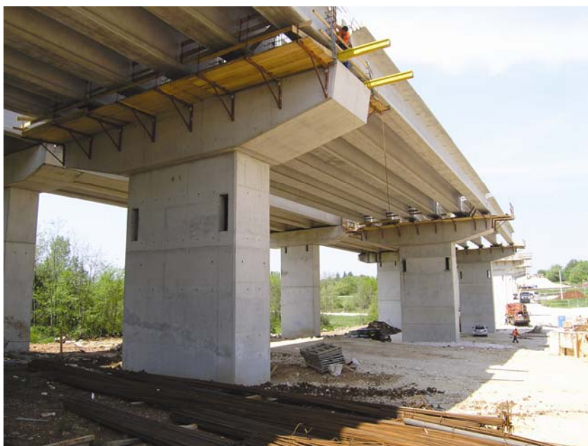
Radovi na vijaduktu Vala – najvećoj prometnoj građevini u 2A fazi
