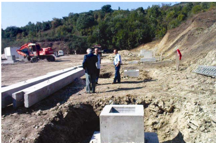
Pripreme za ugradnju predgotovljenih armiranobetonskih nosača
