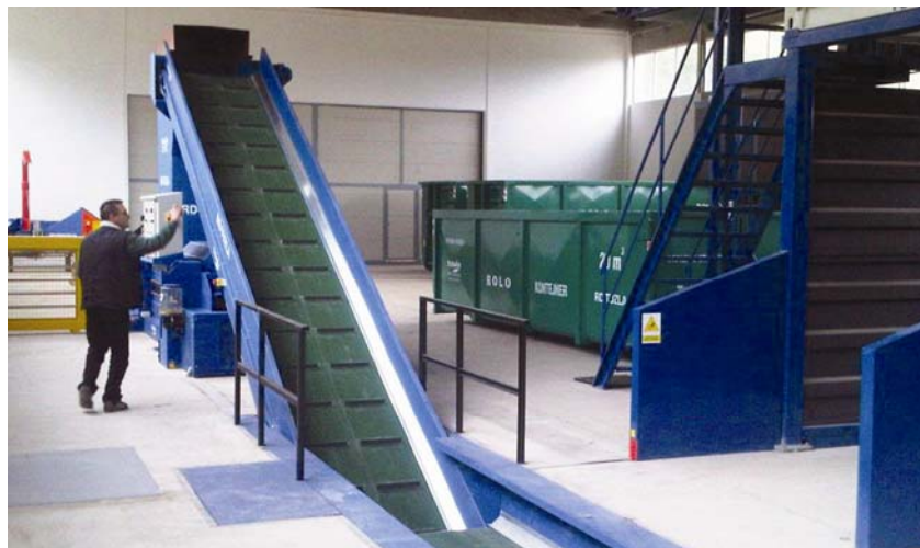
Puštanje linije za razvrstavanje otpada u probni rad
