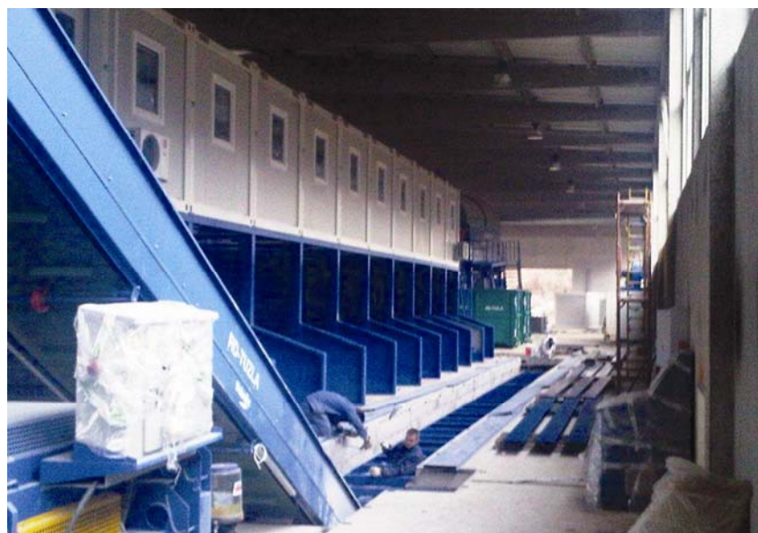
Radovi na montaži opreme
