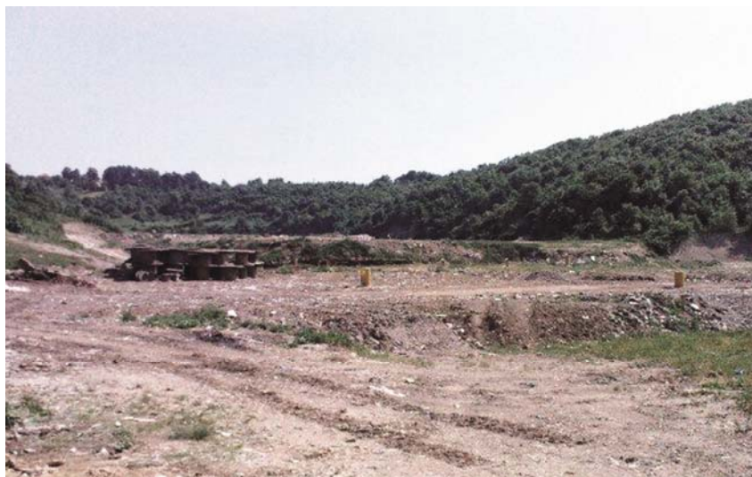
Dio odlagališta Desetine pokraj Tuzle prije početka gradnje hale za gospodarenje komunalnim otpadom
