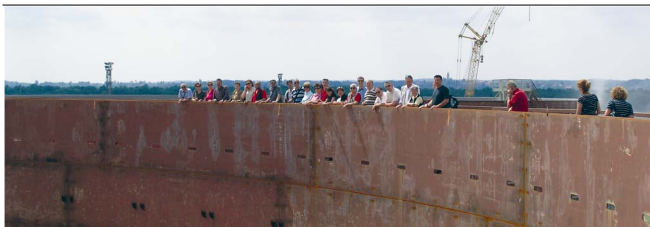
Sudionici skupštine HSGI-a na gradilištu velikoga naftnog spremnika
