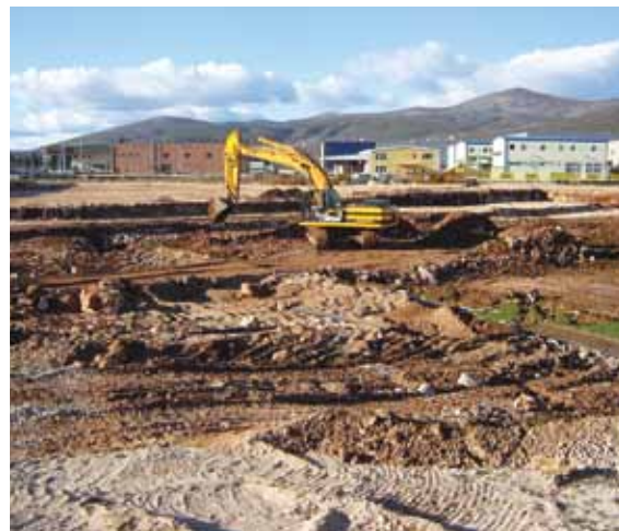
Početak radova na gradnji športskog kompleksa
