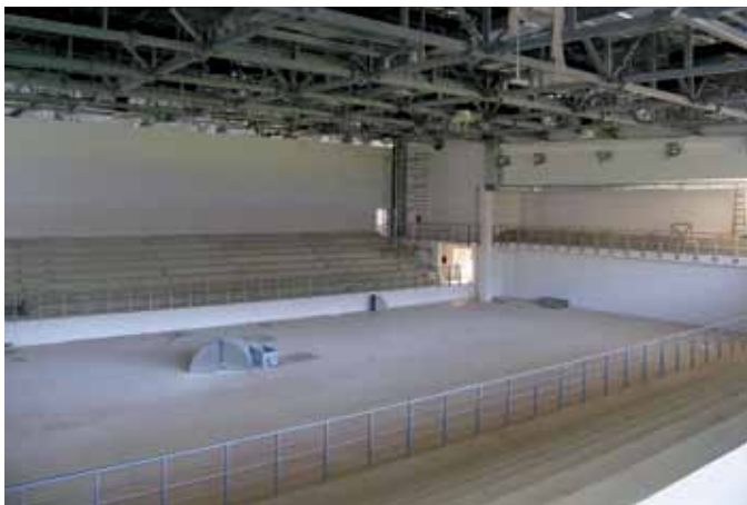
Gradilište zatvorenoga teniskog kluba
