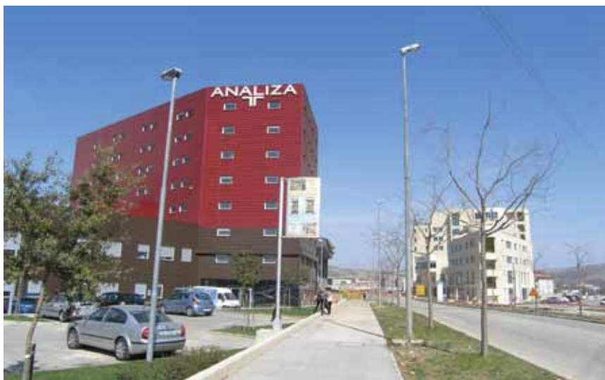
Poliklinika Analiza i poslovna zgrada Mucić & Co. u pozadini
