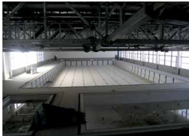
Gradilište bazena tijekom posjeta
