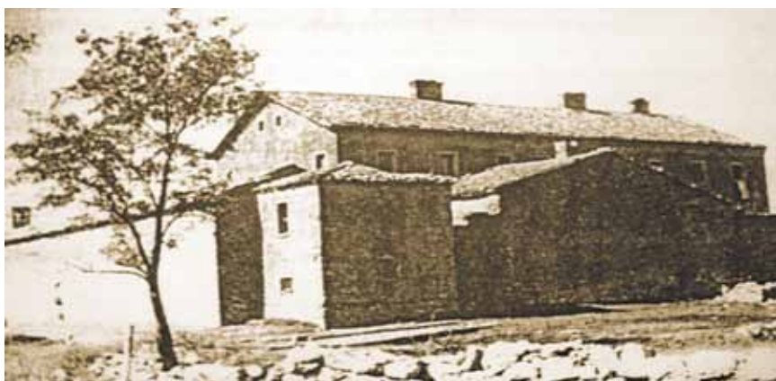
Novi kaštel u Lupoglavu na fotografiji iz 1945.
