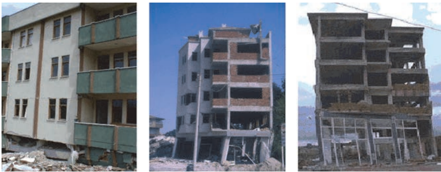
Slika 2. Oštećenja mekih prizemlja nakon potresa
