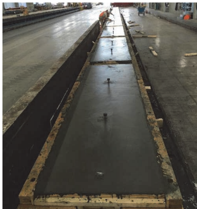
Slika 11. Uzorci greda nakon ugradnje betona
