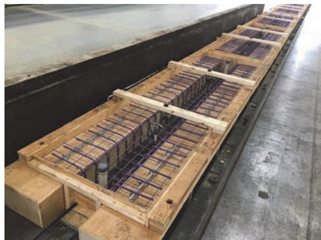
Slika 8. Prikaz ugrađene armature u kalupu prije ugradnje betona
