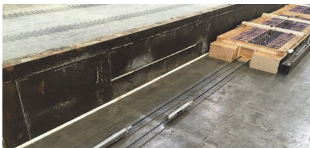
Slika 10. CFCC užad nakon zatezanja
