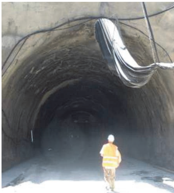
Slika 4. Primarni podgradni sustav tunela Sveti Ilija [24]
