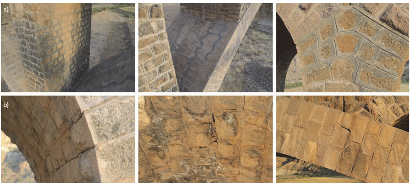
Slika 3. Most Mianeh: a) pogled na popravljene segmente, b) pogled na dijelove u kojima je došlo do ispadanja morta
