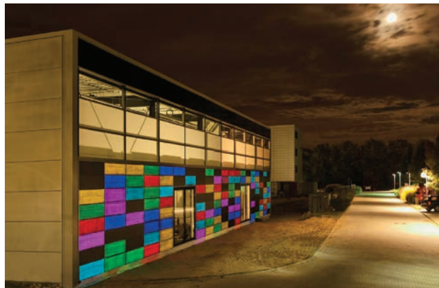
Medijska fasada na Sveučilištu RWTH Aachen
