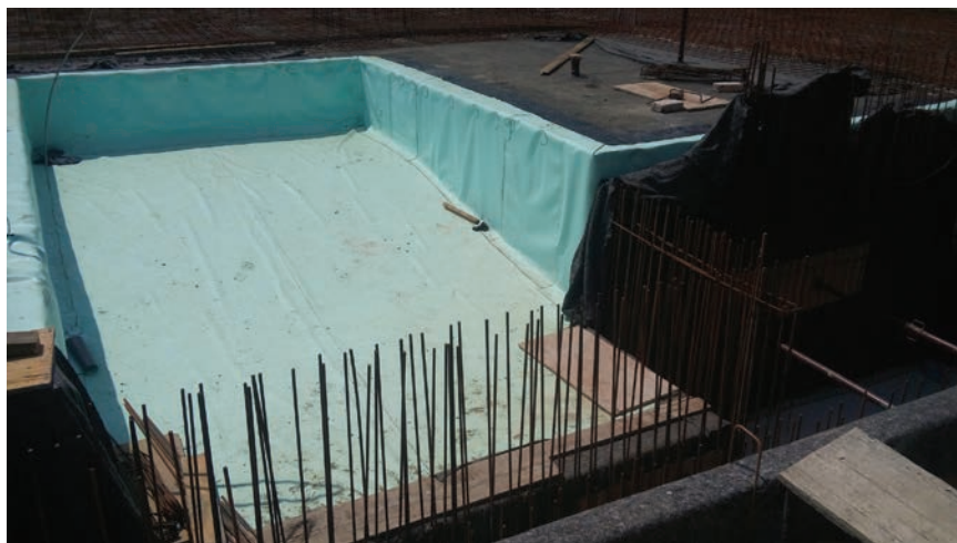
Izolacija bazena u prizemlju građevine
