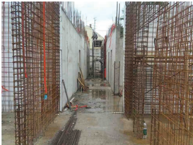
Pogled na gradilište krajem srpnja 2017.
