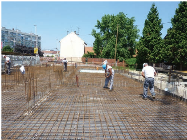
Armirački radovi na podnoj ploči prizemlja
