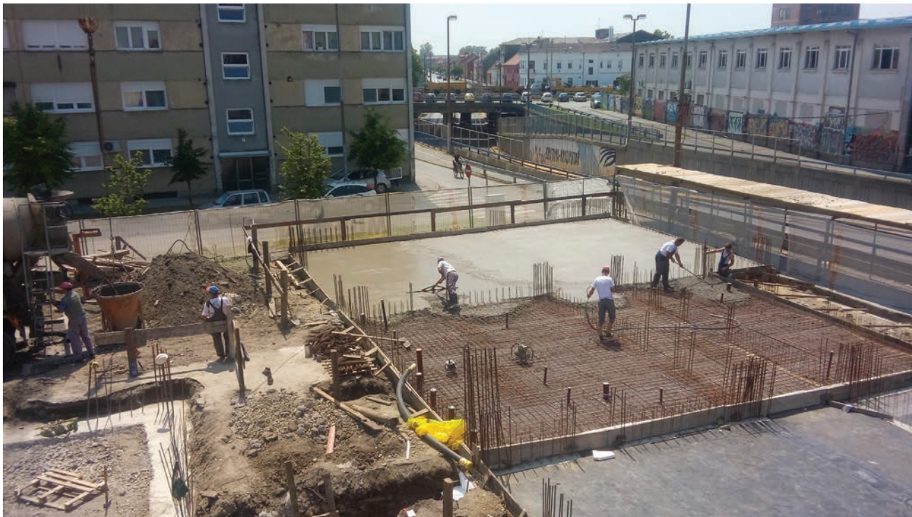
Ugradnja betona u podnu ploču prizemlja
