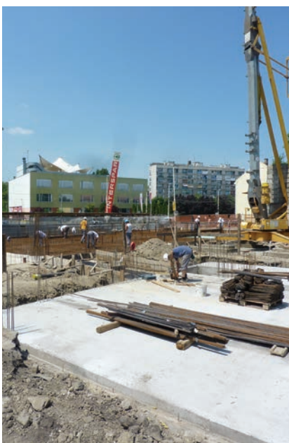
Detalj s gradilišta
