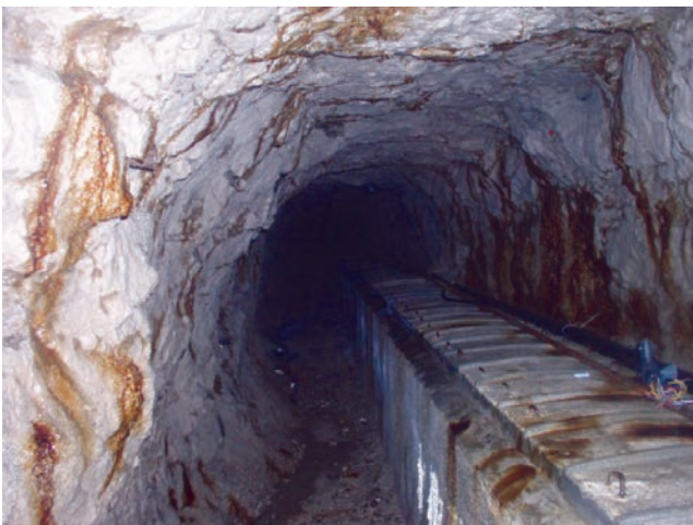
Hidrotehnički tunel kroz Srđ – postojeće stanje
