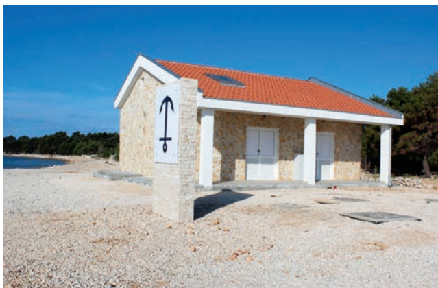
Precrpna stanica sustava odvodnje na obali u Viru (izgrađeno)
