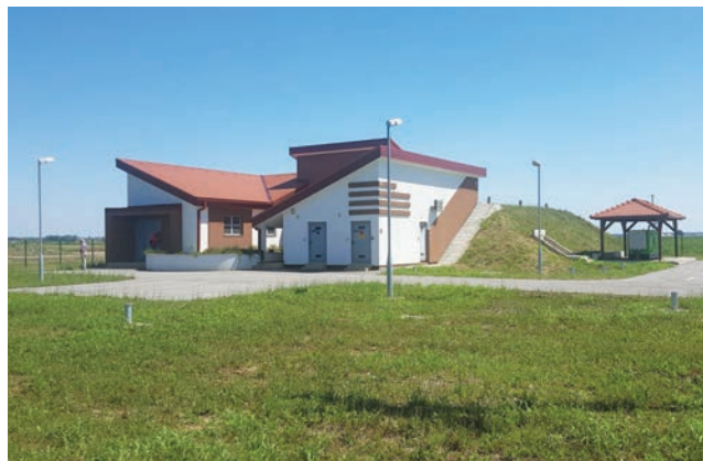
Crpna stanica i vodospremnik Retkovci u općini Ivankovo (izgrađeno)
