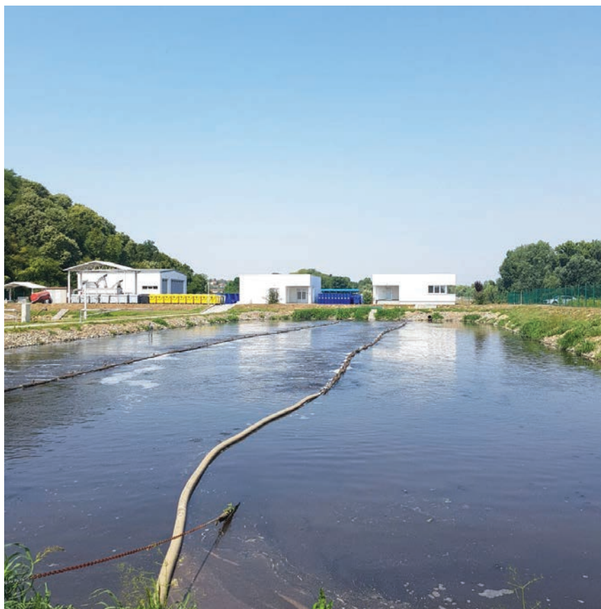
Uređaj za pročišćavanje otpadnih voda u Iloku (izgrađeno)
