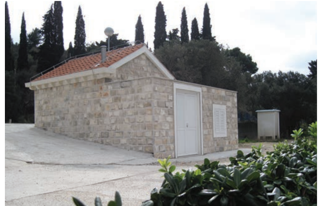
Crpna stanica Glavica u Dubrovniku (izgrađeno)
