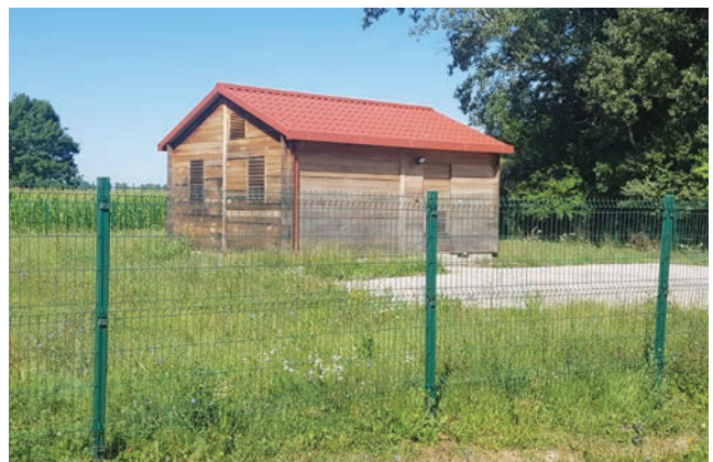
Crpilište Istočna Slavonije u Sikirevcima (izgrađeno)
