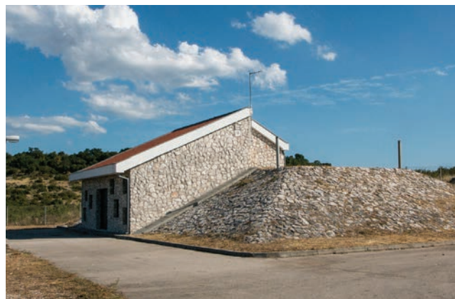
Vodospremnik Marići u šibenskom zaleđu (izgrađeno)
