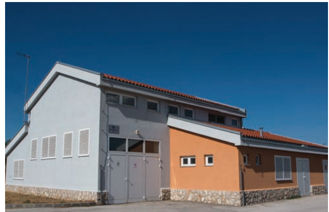
Crpna stanica Biljane Donje u zadarskom zaleđu (izgrađeno)
