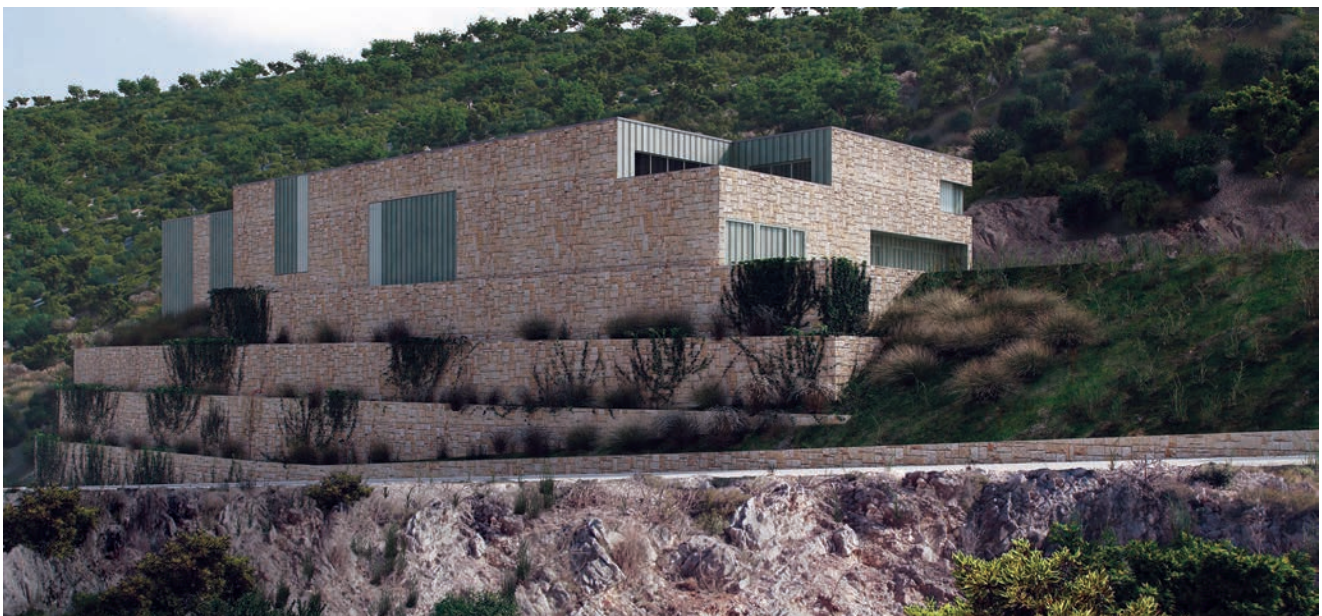
Uređaj za preradu pitke vode Ombla u Dubrovniku (u gradnji)
