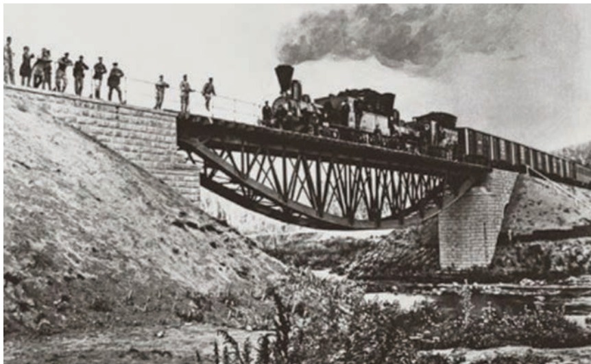
Čelični most kao dio Transsibirske željeznice, konstrukcije oblika ribljeg trupa
