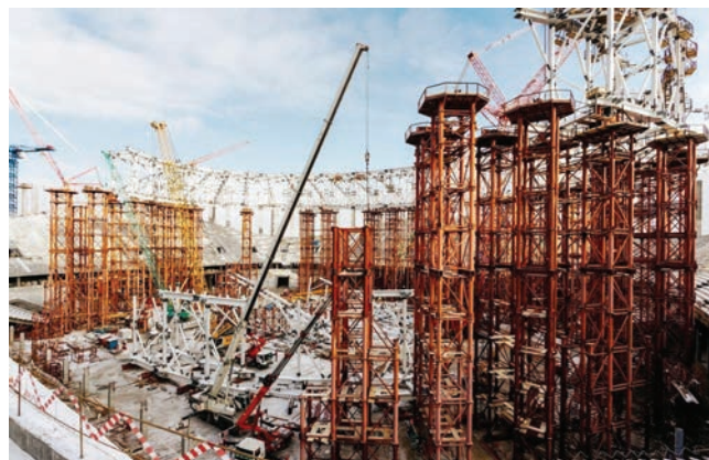
Postavljanje skele za izvođenje čelične konstrukcije krova
