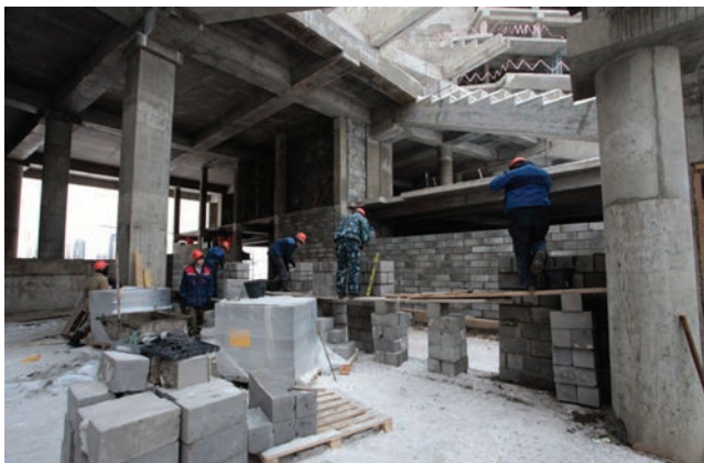
Zidovi podrumске етаже Otkritie Arene u Moskvi izvedeni su od blok opeka, a tribine su monolitni betonski elementi; pročelje Otkritie Arene (desno)
