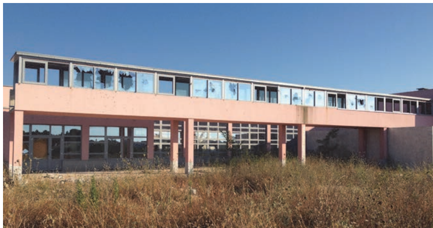
Slika 2. Zatečeno stanje / eksterijer objekta, pročelje, autor: Hrvoje Bajlo, 2018.
