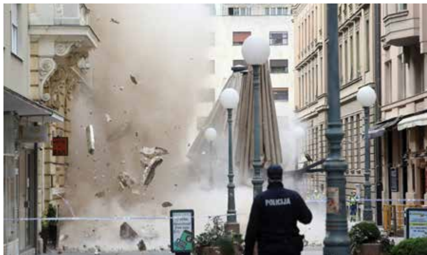
Trenutak snimljen tijekom kontroliranog rušenja opasnih dijelova s vrhova zgrada u središtu grada (Foto: Spegra)
