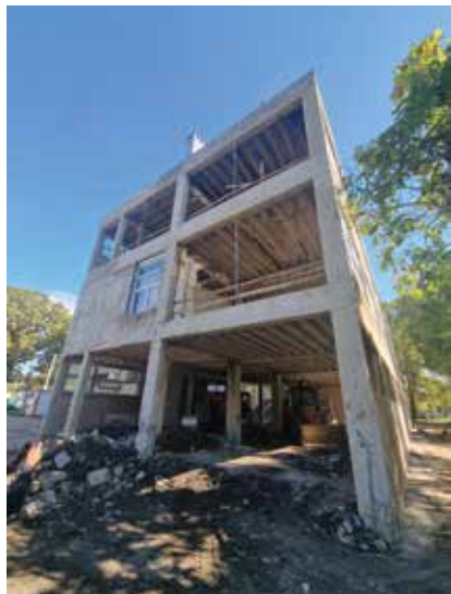
Ogoljena nosiva konstrukcija paviljona prije nastavka radova
