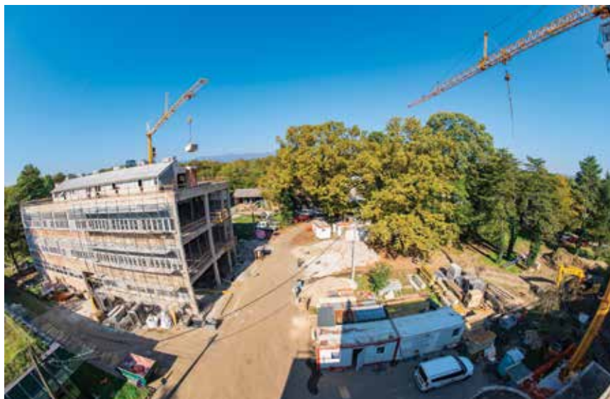
Jedan od pogleda na gradilište
