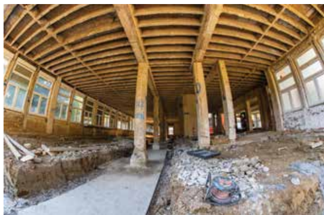
Izvođenje novih temelja u Paviljonu I
