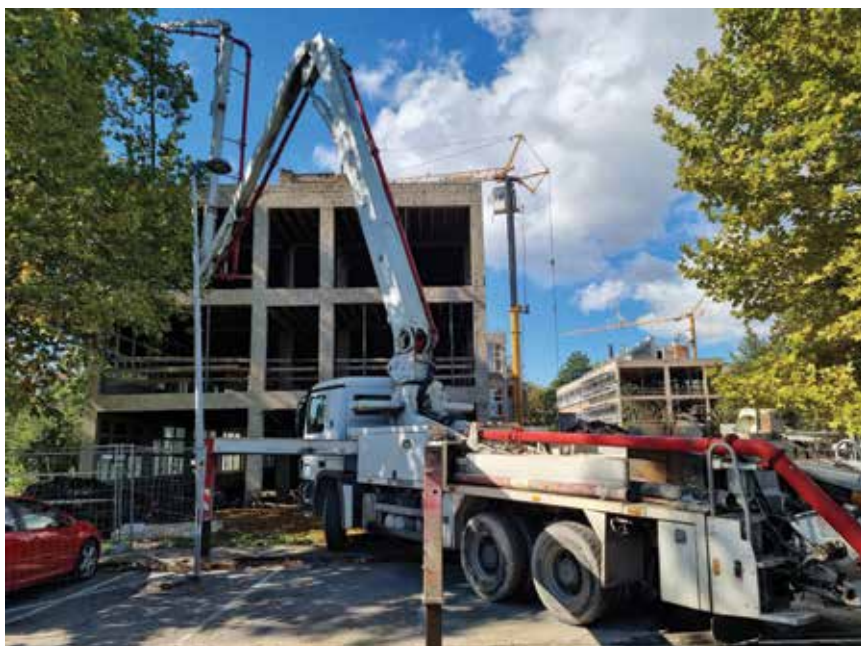
Betoniranje novih konstruktivnih elemenata
