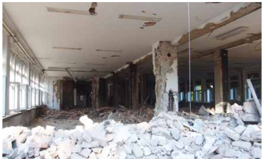
Rušenje svih pregradnih zidova u paviljonu I
