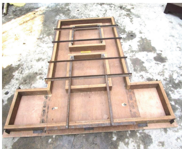
Slika 2. Kalup za izradu ispitnog uzorka betonskog okvira
