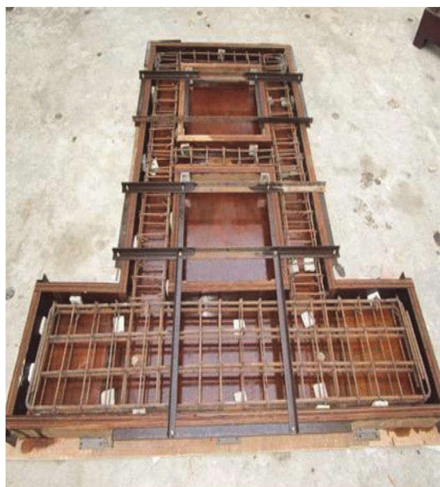
Slika 4. Oplata s rasporedom armature
